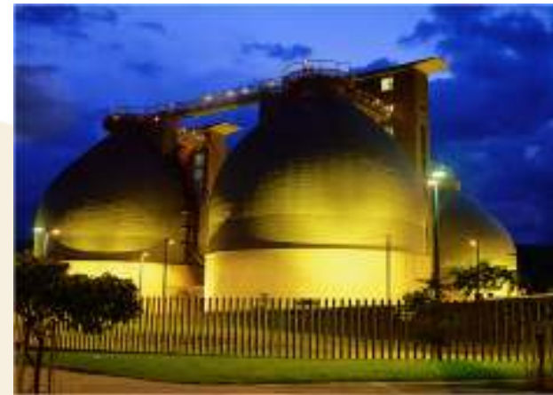
Biodigester Planta San Fernando
